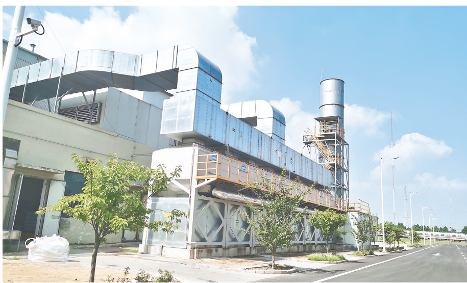
郑州中车四方轨道车辆有限公司“活性炭吸附+脱附+CO催化燃烧”环保设施投入使用以来，大大减少了车辆喷漆时的污染物排放浓度和排放量
