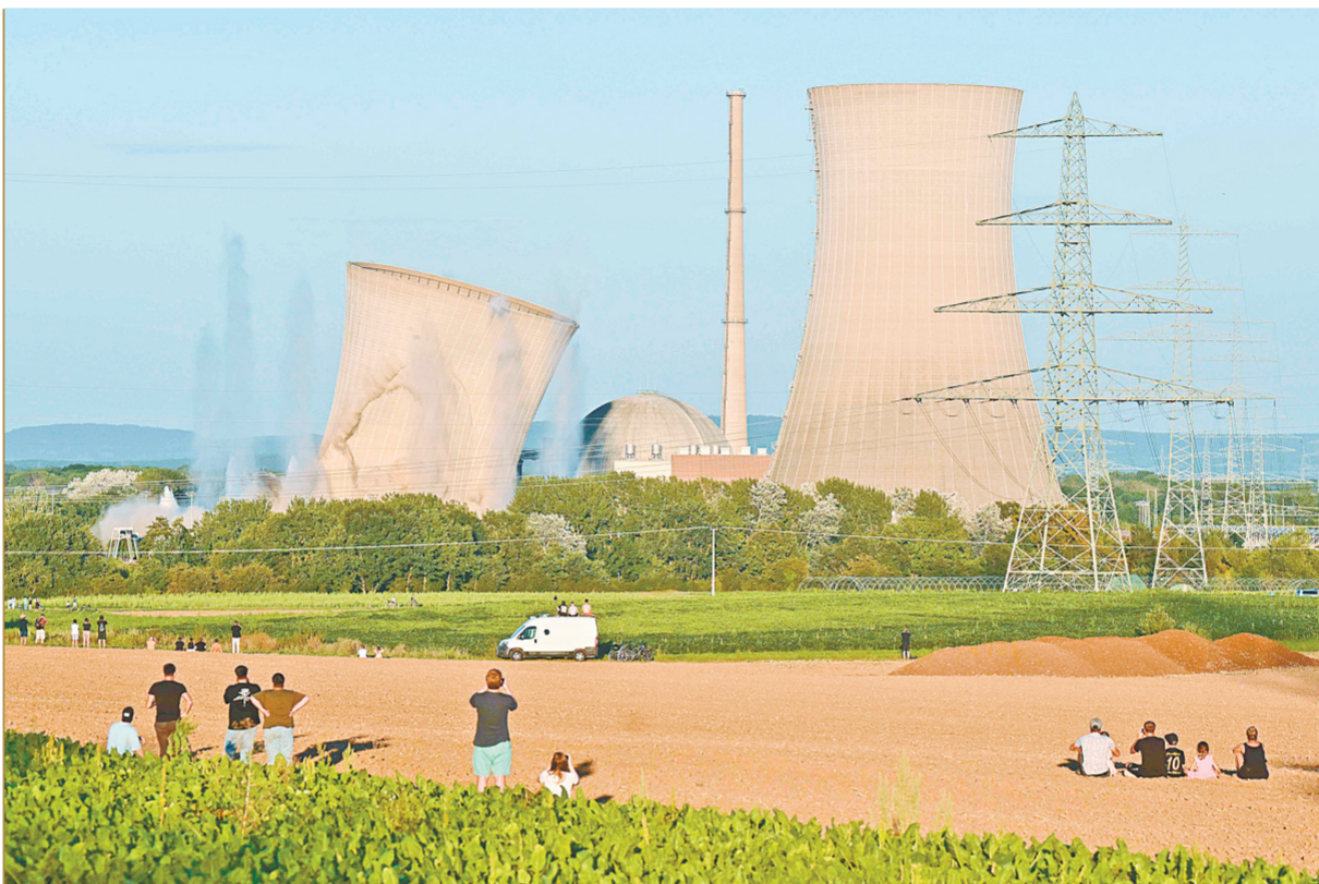
8月16日，在德国格拉芬莱茵费尔德，人们观看核电站的冷却塔被爆破拆除。德国曾将核电作为重要电力来源。2011年，受日本福岛核事故影响，德国决定逐步弃用核能，关闭所有核电站，并推进可再生能源发展。 新华社法新
