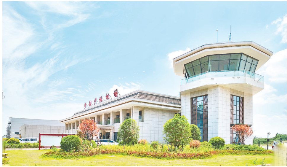
登封少林机场开始试运行 中豫航空供图
