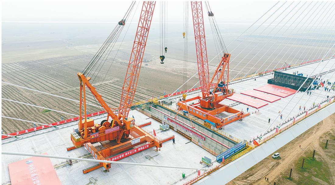
米、单跨顶推距离100米、同时控制步履千斤顶数量80台三项“国内第一”,填补了多项国内技术空白。
