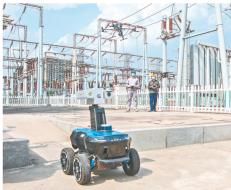
运维人员利用机器人对变电站设备开展巡视
