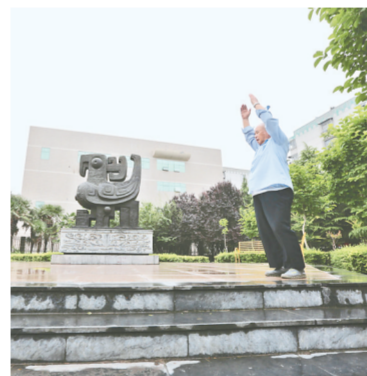
位于市中心的220千伏人民变电站与旁边公园融为一体
