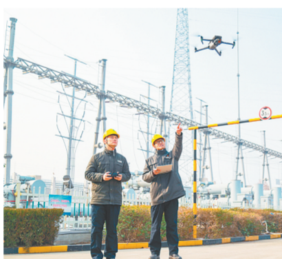
运维人员利用无人机开展设备巡视
