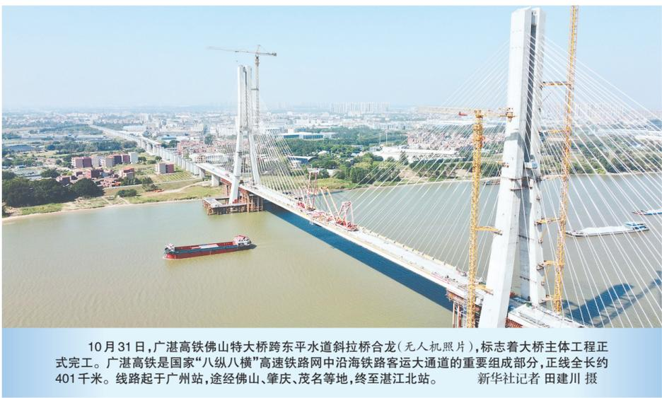
10月31日，广湛高铁佛山特大桥跨东平水道斜拉桥合龙(无人机照片)，标志着大桥主体工程正式完工。广湛高铁是国家“八纵八横”高速铁路网中沿海铁路客运大通道的组成部分，正线全长约401千米。线路起于广州站，途经佛山、肇庆、茂名等地，终至湛江北站。
