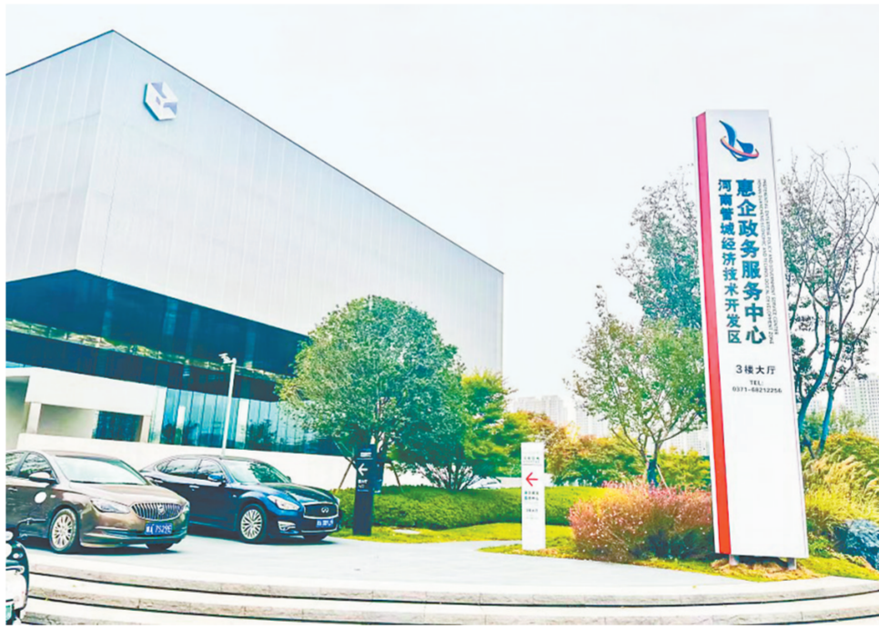
金盏产业园区
