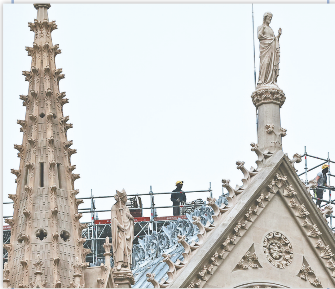
12月4日,工人在即将重新开放的法国巴黎圣母院忙碌。历经5年多的修复,法国巴黎圣母院将于12月7日至8日举行重新开放仪式,8日起对公众开放。2019年4月15日,圣母院的屋顶和塔尖在大火中被烧毁。 新华社记者 高静摄
