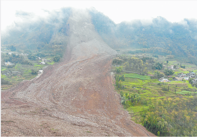
这是2月8日拍摄的滑坡现场 新华社发
