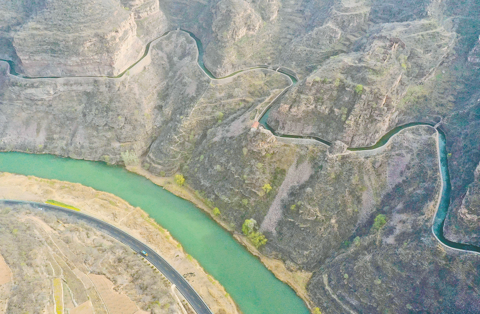
在河南省林州市红旗渠风景区附近拍摄的红旗渠总干渠（2025年3月25日摄，无人机照片）
