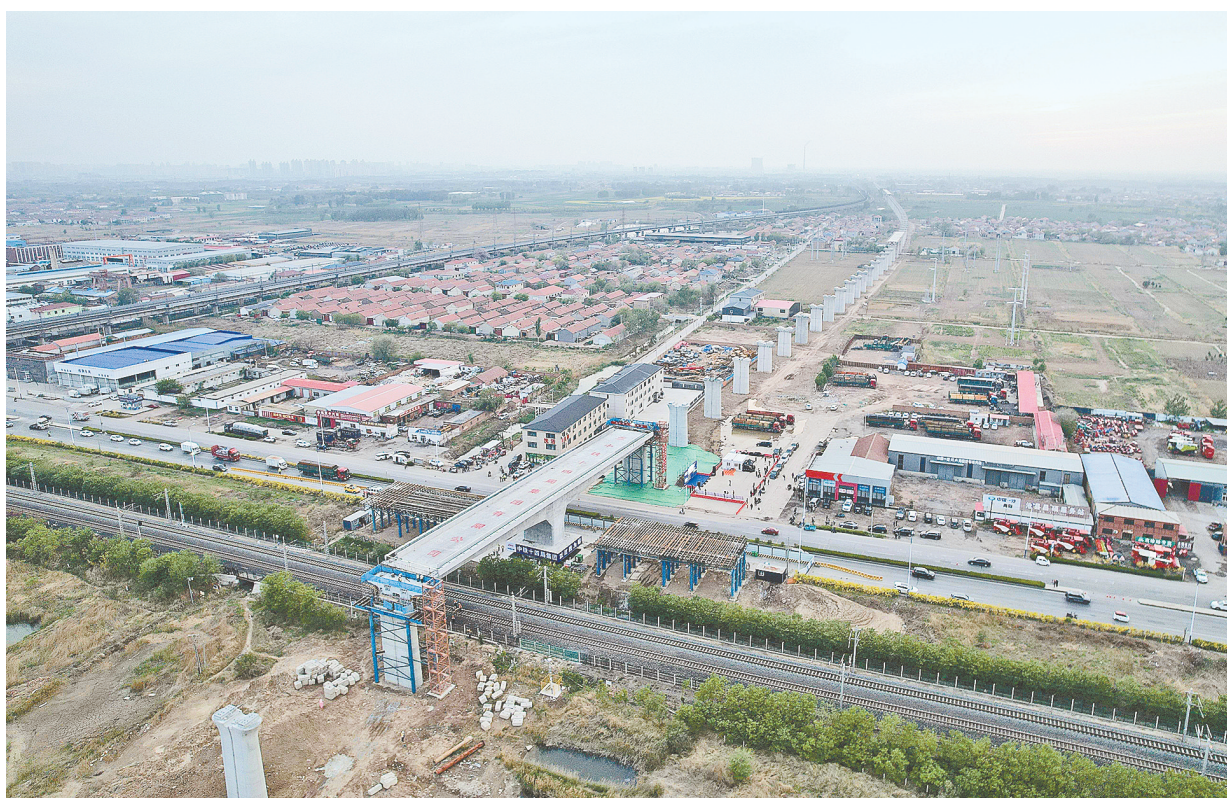
4月22日拍摄的石衡沧港城际铁路跨京沪铁路转体桥（无人机照片）。当日，由中铁十四局集团承建的石衡沧港城际铁路跨京沪铁路转体桥转体完成。该桥位于河北省沧州市沧县姚官屯镇，是全线重点控制性工程。石衡沧港城际铁路是京津冀城市群“四纵四横一环”城际铁路网中的重要组成部分，西起石家庄，东至渤海新区，设计速度250公里每小时。
