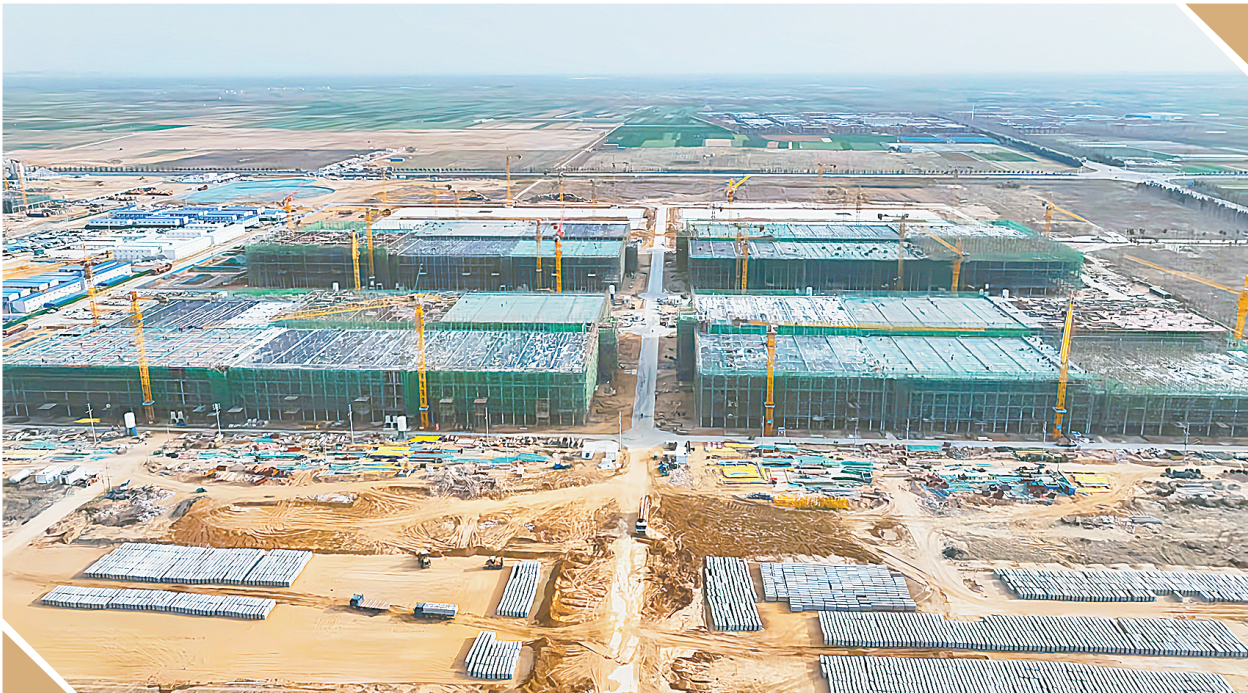
中原现代食品产业园项目施工现场
