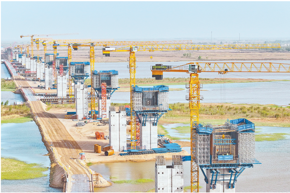
5月8日，由内蒙古路桥集团和中交二公局承建的国道110线磴口黄河大桥工程全面进入预制梁架设和上部箱梁悬浇作业阶段，标志着整个大桥进入上部结构施工阶段。该工程横跨内蒙古自治区巴彦淖尔市磴口县与鄂尔多斯市杭锦旗黄河两岸，全长3098米，是国道110线北京至宁夏青铜峡公路的控制性工程。新华社发
