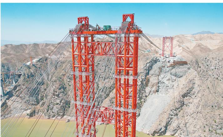
这是5月10日拍摄的兰永临高速公路洮河大桥缆索吊装系统(无人机照片)。当日，由中铁二十局承建的兰(兰州)永(永靖)临(临夏)高速公路关键控制性工程洮河大桥500吨大型缆索吊装系统试吊成功，标志着这一横跨洮河的上承式钢管混凝土拱桥正式进入主体结构施工阶段。洮河大桥是兰永临高速公路的“咽喉”工程，大桥全长562.16米，主桥采用净跨400米上承式钢管混凝土拱桥设计。
