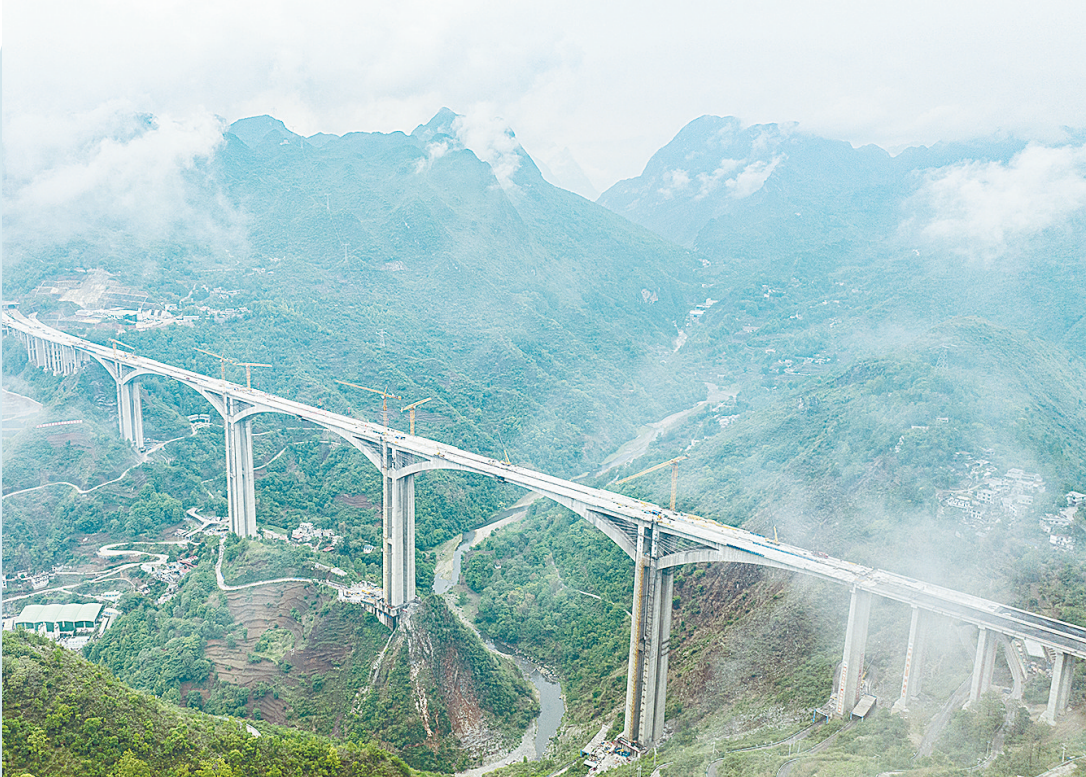
顺利实现合龙的纳晴高速六枝特大桥（5月15日摄，无人机照片）。当日，由贵州路桥集团承建的纳晴高速六枝特大桥顺利合龙，为推动纳（雍）晴（隆）高速全线通车的目标奠定了坚实基础。六枝特大桥位于贵州省六盘水市六枝特区中寨乡境内，是纳雍至晴隆高速公路的控制性工程，大桥全长2023.5米，桥面距谷底水面净空315米。
