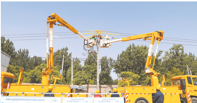
不停电综合检修
