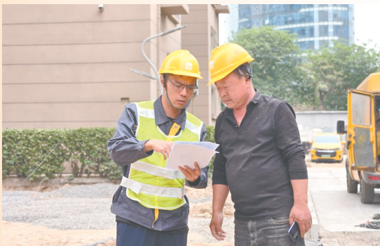
庭院老旧管网改造施工
