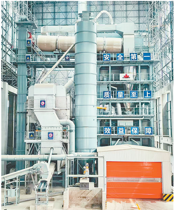
郑州建设集团郑发市政新型路面材料基地实现三大生产线智能化管控 本报记者 徐宗福 摄
