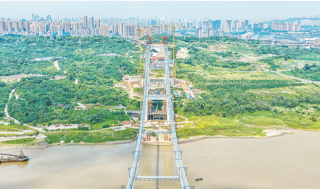
这是7月30日拍摄的重庆黄桷沱长江大桥主缆架设作业现场(无人机照片)。
