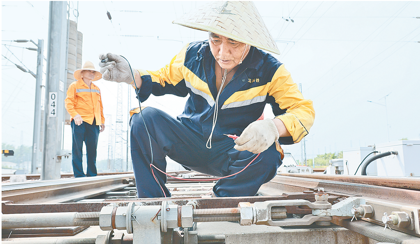
郑州高铁基础设施段内，工作人员顶着烈日进行道岔检修作业
